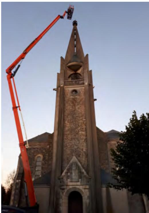
En octobre dernier, la municipalité a entrepris des travaux de mise en sécurité de l'église (remplacement d'ardoises, restauration des pierres de Tuffeau menaçantes, nettoyage des gouttières...). Les entreprises L'Aigle de Haute Goulaine et Chantereau couverture de Fercé, ont réalisé ces opérations, à l'aide d'impressionnants moyens de levage.
